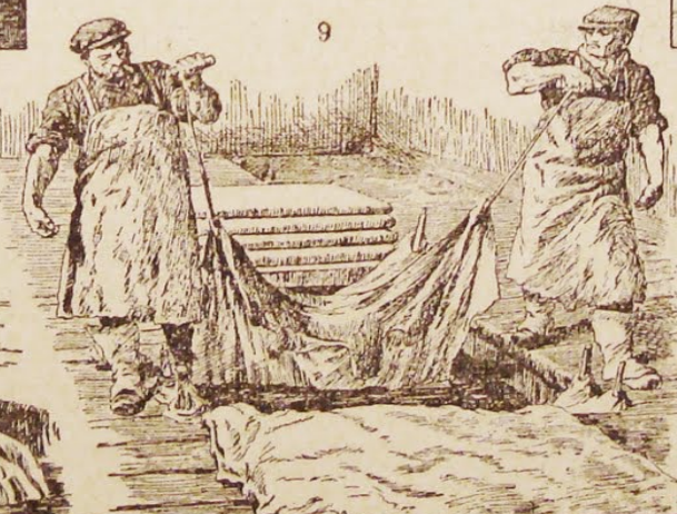
CURTUME: 1. Transporte e manipulação de couros verdes; 2. Descabellamento, e 3. Descarnadura dos couros brutos; 4. Collocação no tanque de lavagem; 5. rrisamento; 6. Divisão d'uma pelle; 7. Lavagem no bombo; 8. Pelle conduzida á machina de desborrar; 9. Lavagem da cal; 10. Descarnadura mechânica.
